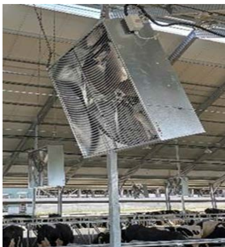
BOX-FAN MET AC-MOTOR
